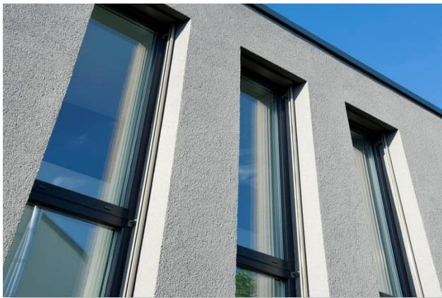
Le châssis de fenêtre et de la porte-fenêtre est en aluminium, type SCHÜCO ou similaire (valeur Uf définie suivant le calcul énergétique). Ils sont équipés d'un triple vitrage isolant (valeur Ug définie suivant le calcul énergétique).
